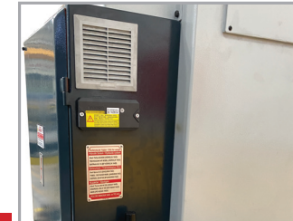
Elektrik panosu soğutma ve havalandırma sistemi Electric panel fan and ventilating system
